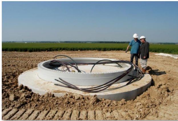
Photo 141 : Fondation terminée (Photo : VALOREM)
