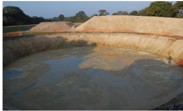
Photo 138 : Excavation (Photo : VALOREM)
