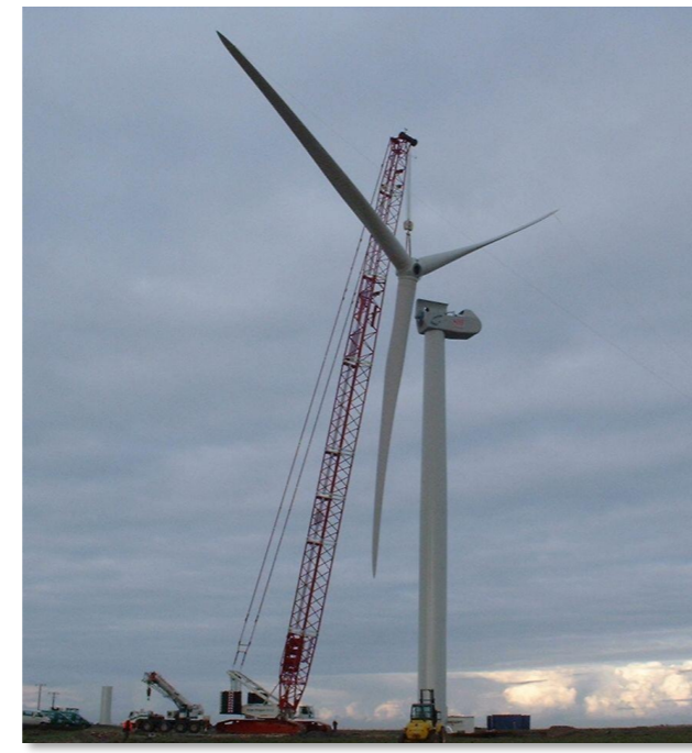
Photo 146 : Mise en place du rotor tripale (Photo : VALOREM)
