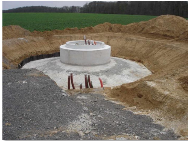
Photo 140 : Béton terminé (Photo : VALOREM)
