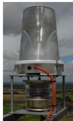
Photo 136 : Exemple de balise (feux à éclats blancs et rouges ; source VALOREM)
