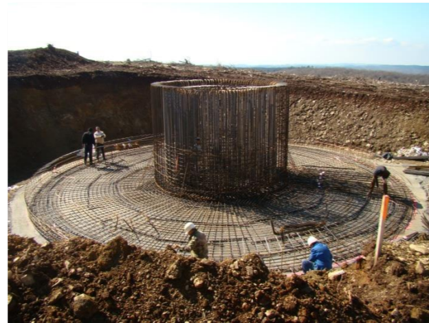
Photo 139 : Armature (Photo : VALOREM)
